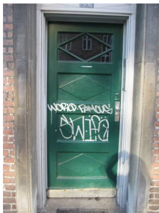
Gadedør til hovedtrappe.
