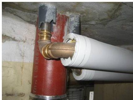
Uisoleret stigstreng/ledning
